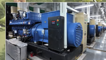
112*2000kW 10.5kV 50Hz 开放式机组
