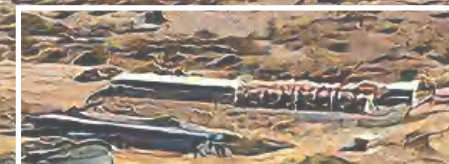
7*1600kW 10.5kV 50Hz 集装箱式
