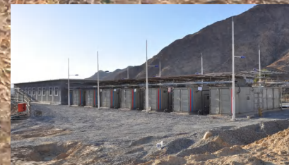
7*1600kW 10.5kV 50Hz 集装箱式
