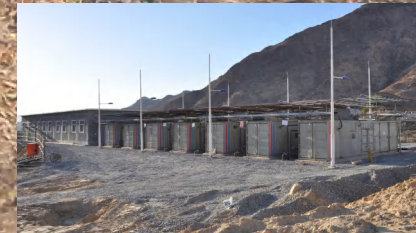
7*1600kW 10.5kV 50Hz Container type
