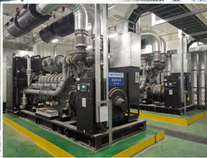
10*1600kW 0.4kV 50Hz Open Type
