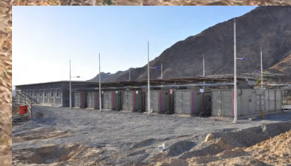
7*1600kW 10.5kV 50Hz Container type
